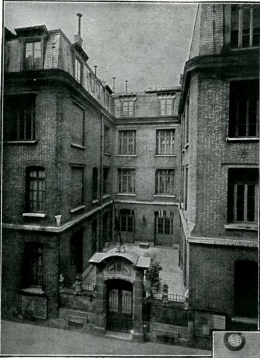
L'école des filles de la rue de Monceau, à Paris, chauffée tout entière au chauffage électrique Mécano.
